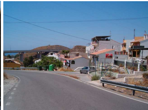
Carretera actual. Viaducto ronda circunvalación.
