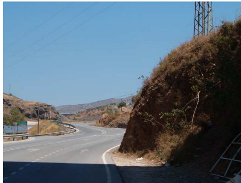
Inicio Carretera Olías
