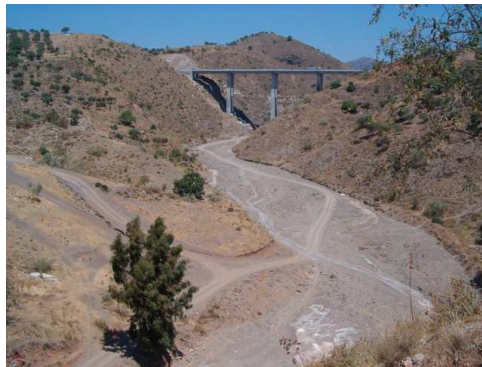
Arroyo Gálica y viaducto autovía
